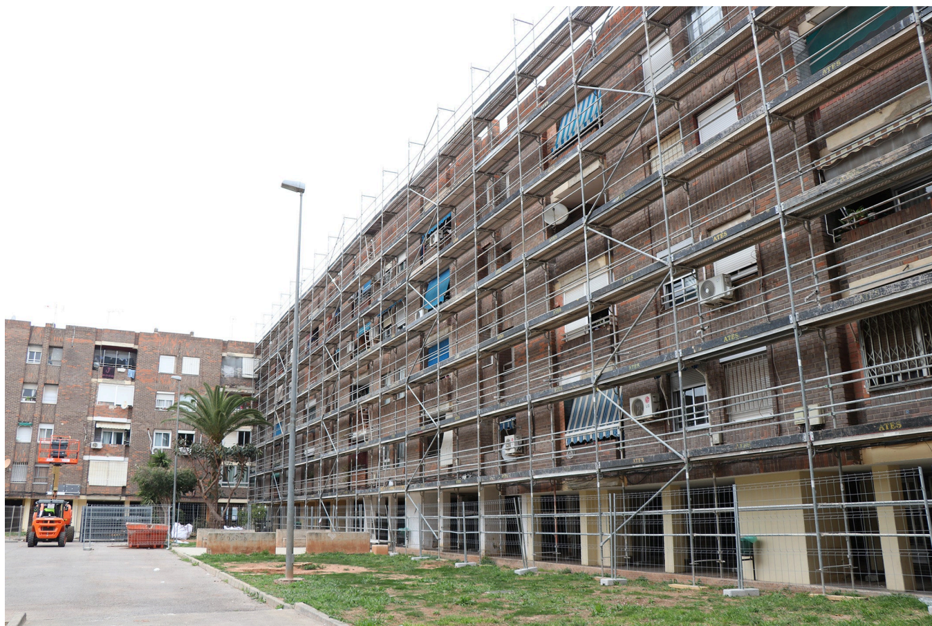
Andamios colocados en la zona donde se va a actuar. LP
