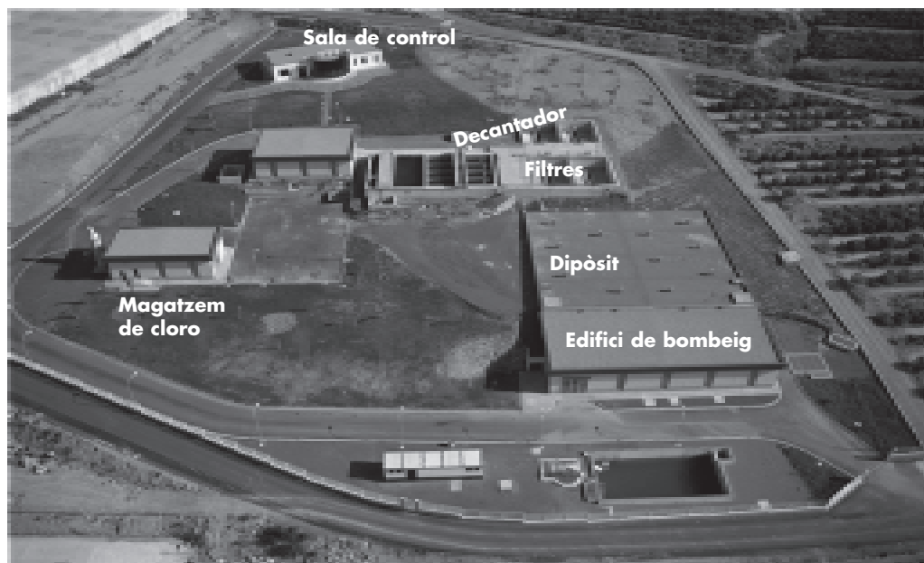
Planta potabilitzadora de Sagunt. Foto: ARXIU PLANTA
