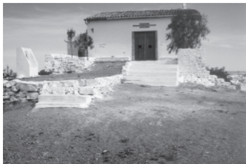
Ermita de Sant Cristòfol. Anys 90. Estat actual de l'ermita després de la restauració.
