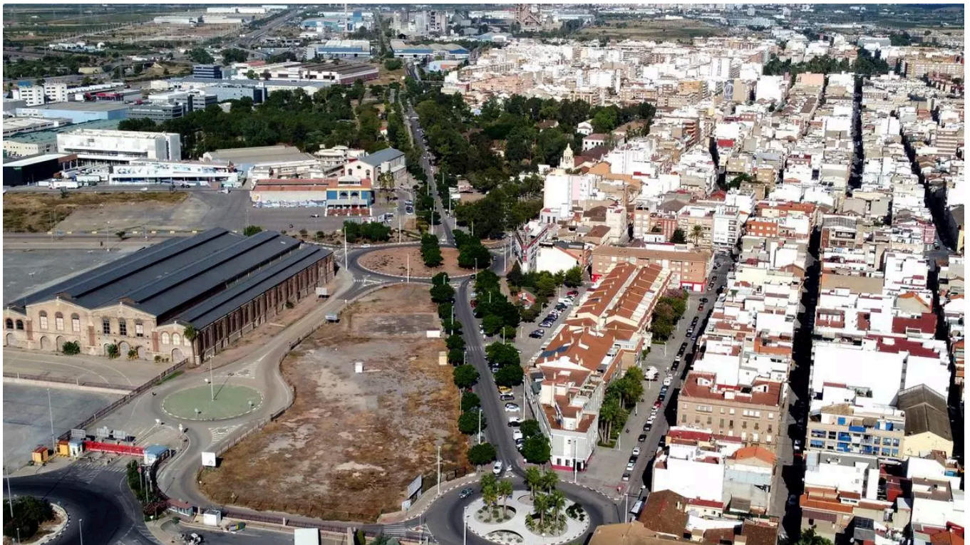
Vista aérea de la zona donde se va a actuar. / Ayuntamiento de Sagunt
