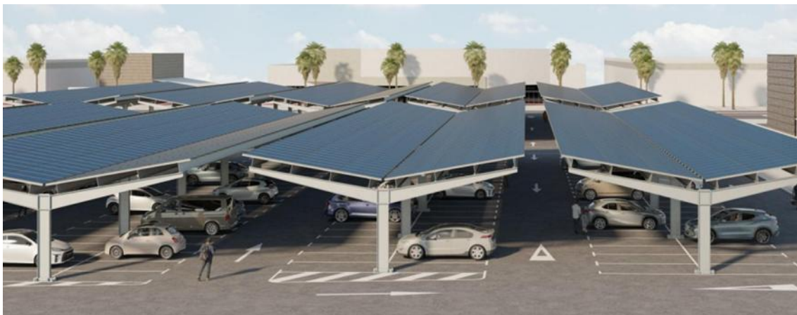
Ejemplo de marquesinas fotovoltaicas en parking vehículos. Fuente: PDTCM.
