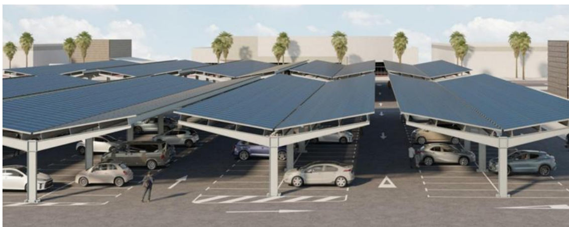
Ejemplo de marquesinas fotovoltaicas en parking vehículos. Fuente: PDTCM.
