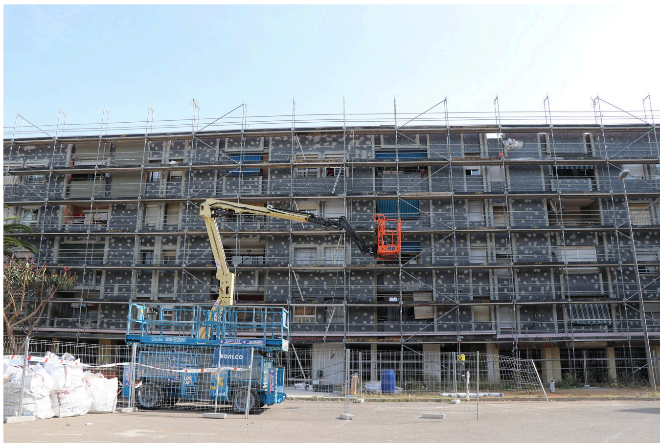
Obras en Sagunto. (LP)
