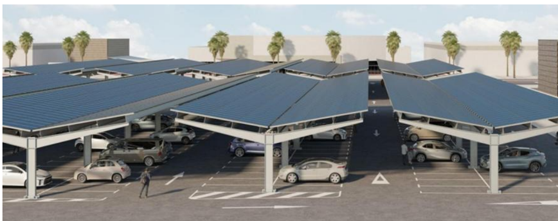
Exemple de marquesines fotovoltaiques en pàrquing vehicles. Font: PDTCM.
