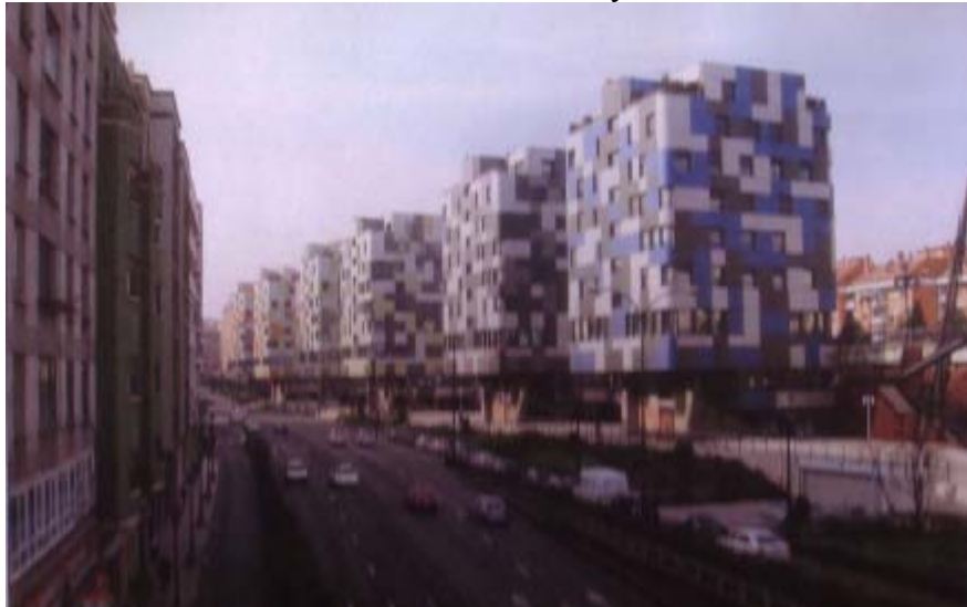
Arriba y abajo. Detalle del tratamiento urbanístico del borde del cubrimiento de la vía del ferrocarril.
